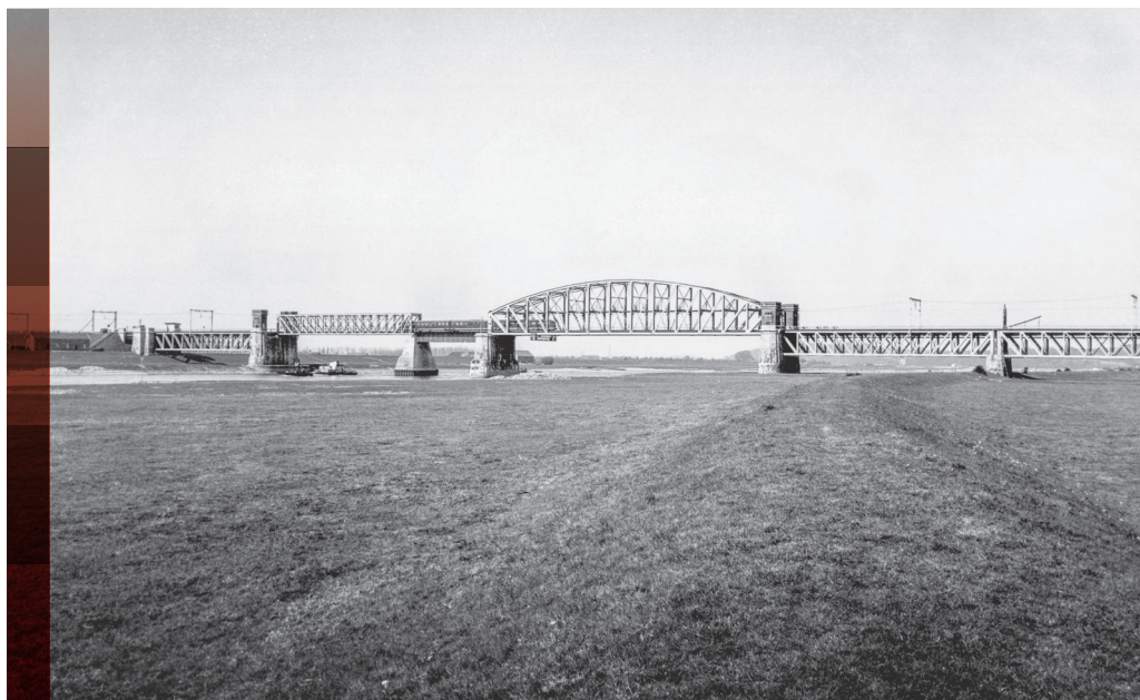
De spoorbrug bij Oosterbeek, gezien vanuit het oosten. (Foto Utrechts Archief - 153548)
